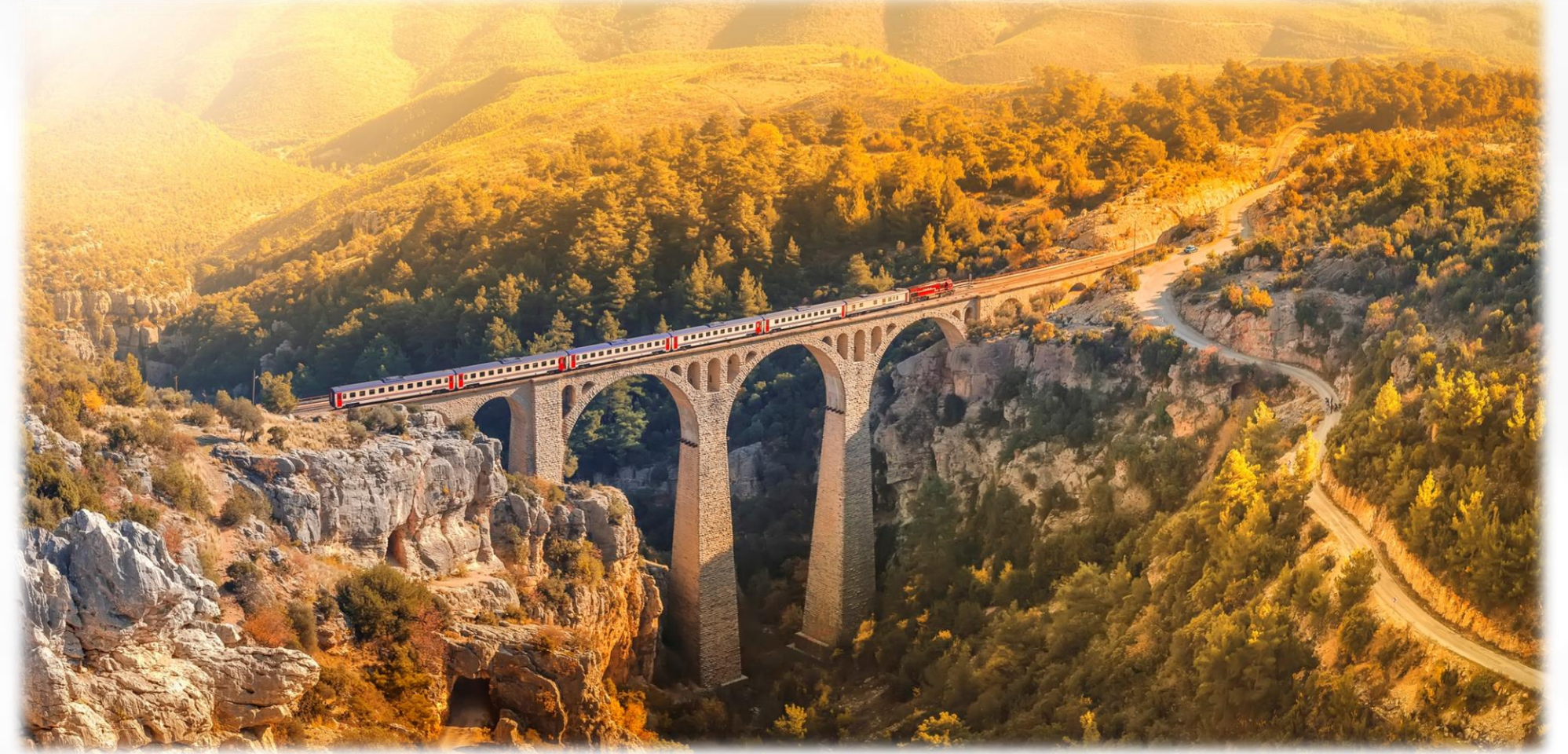
Demiryolu - Adana Varda Köprüsü
